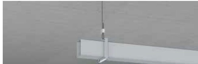
Eléctrico: bandeja para cables
